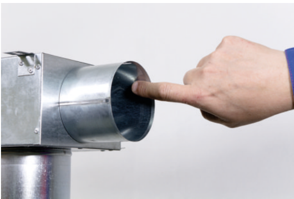
3) Vnitřní povrch vyústku namažeme kluzným přípravkem*.
