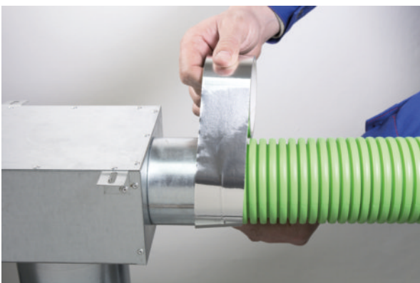
7) Spoj zajistíme vzduchotěsnou lepicí páskou.
